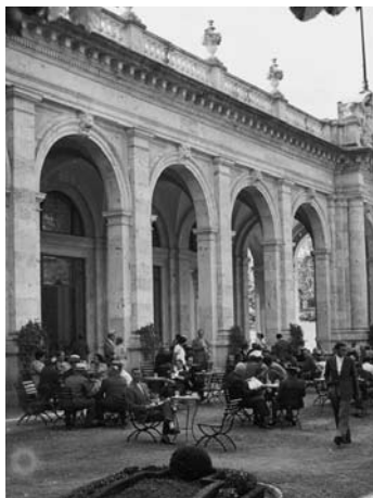
Particolare del porticato dello Stabilimento Regina
